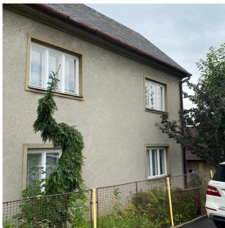
DŮM PUSTÁ POLOM, PŘED REKONSTRUKCI
